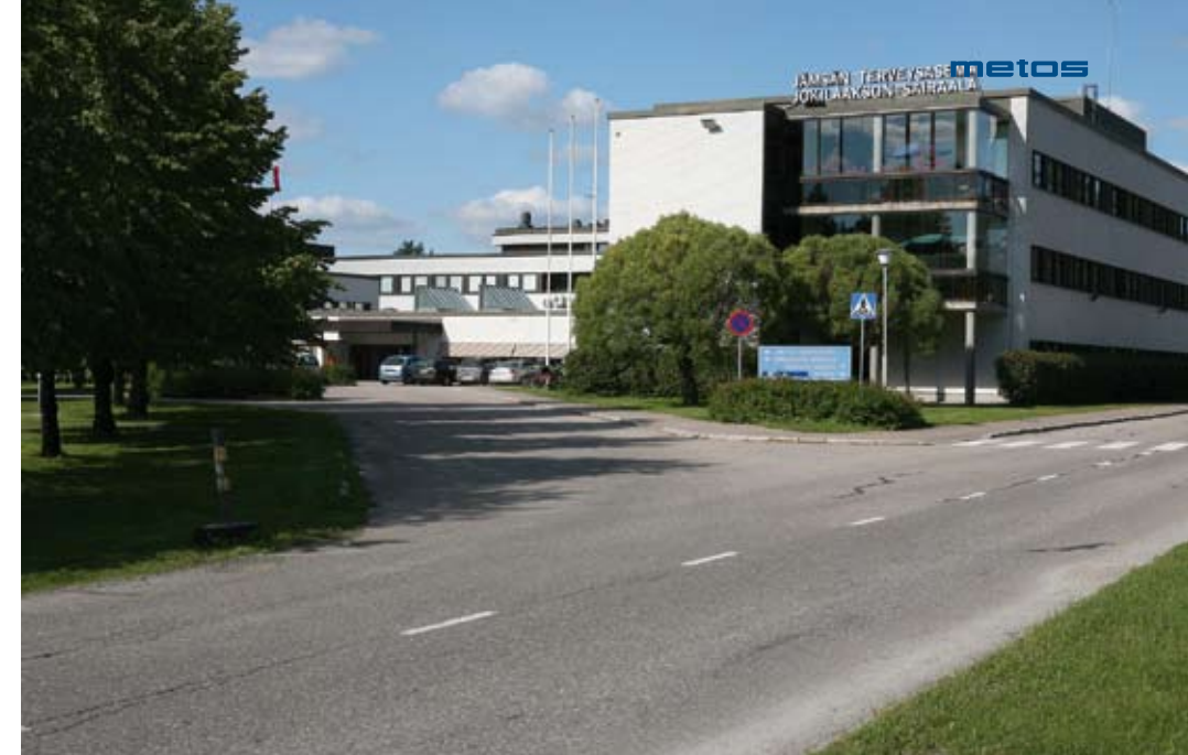
Jokilaakson sairaala Jämsässä. Uusi keskuskeittiörakennus sijaitsee talon takaosassa.
